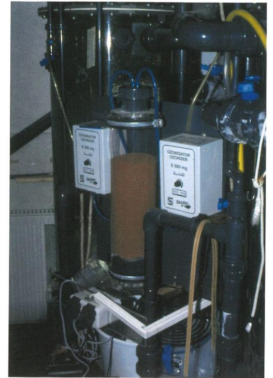
Teilansicht der Filteranlage: Zur Verringerung der Keimdichte tragen zwei 500-mg-Ozonisatoren, dazwischen ein Lufttrockner, und UV-Lampen bei. Das Ergebnis ist kristallklares Wasser ohne Gelbstich
